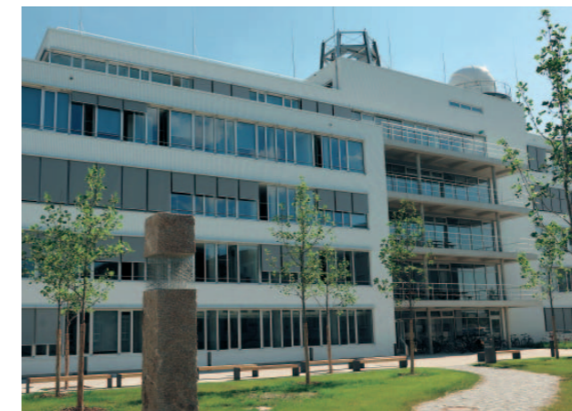
Das DLR-Institut für Kommunikation und Navigation besteht seit 1966. Im Mai 2013 erhielt es für seine 140 Mitarbeiterinnen und Mitarbeiter ein neues Gebäude.
