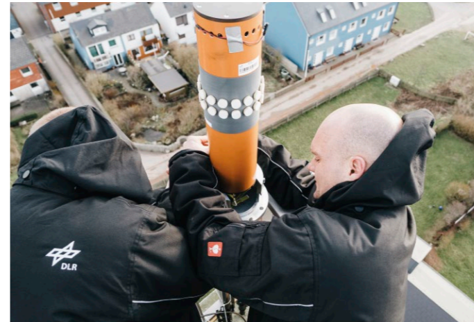
Deutschlands lichtstärkster Leuchtturm wird zum Standort für die Signalübertragung zwischen Schiff und Land. Hoch über Helgoland installieren die DLR-Wissenschaftler ihre Antennen.
