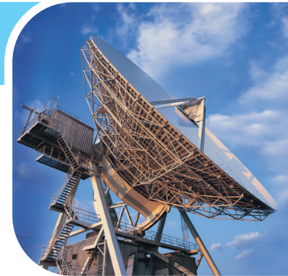
DLR-Bodenstation mit der großen 30-Meter-S-Band-Antenne
