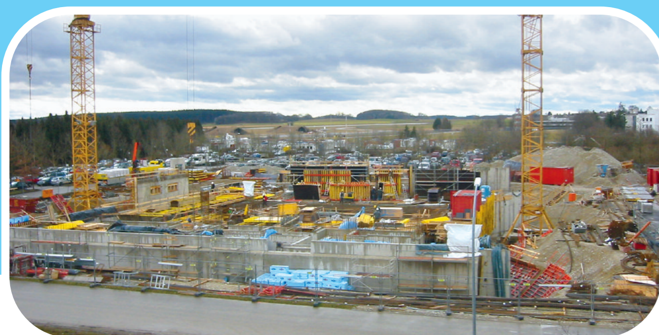
Das neue Gebäude des Satellitenkontrollzentrums nimmt Gestalt an
