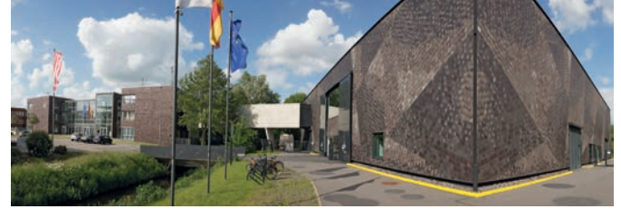
Außenansicht des Instituts für Raumfahrtsysteme
