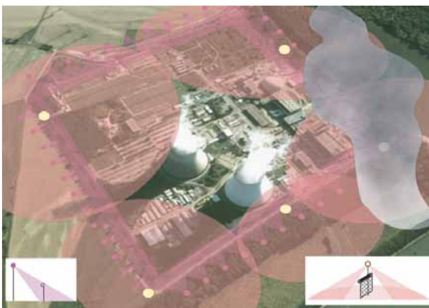
Beispiel zur großflächigen Überwachung eines Kernkraftwerks. Große Areale innerhalb und außerhalb der Anlage (rosa Kreisflächen) sowie Zaunanlagen (kleine Teilbilder) können permanent gegen Eindringen unbefugter Personen überwacht werden.
