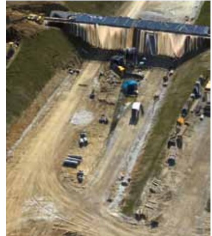
Digitales Oberflächenmodell einer Baustelle
