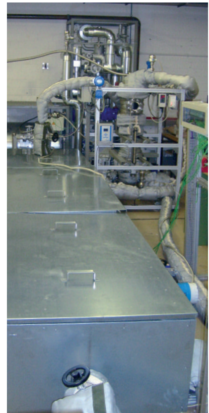
Latentwärmespeicher im DLR-Labor.
