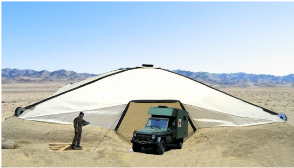
Abb. 6: Designstudie Temporäre Architektur : Entfaltbares Leichtbauzelt für den Einsatz im Katastrophenschutz.
