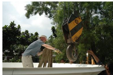
Mitarbeiter des CoE bei der Installation der Antenne in Jakarta.
