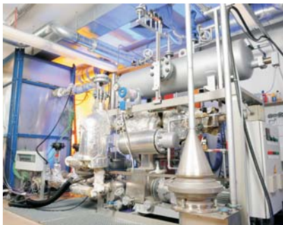
4 kW-Speichertestanlage für Testbetrieb bis 400 °C
