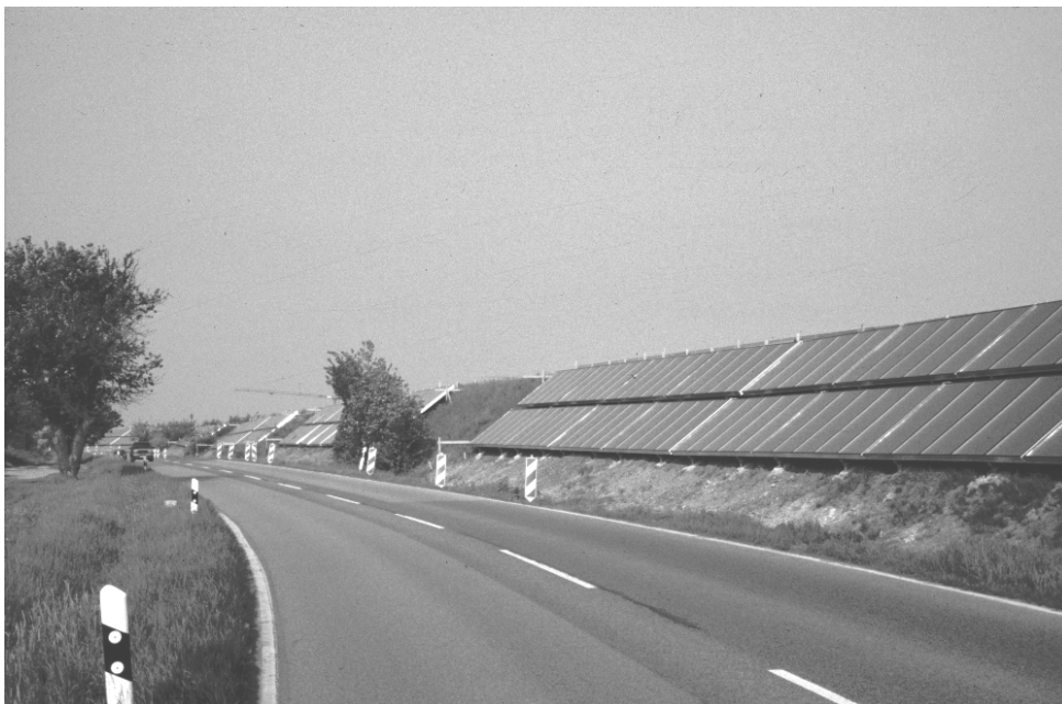
Abbildung 14. Kollektor auf Lärmschutzwand in Amorbach
