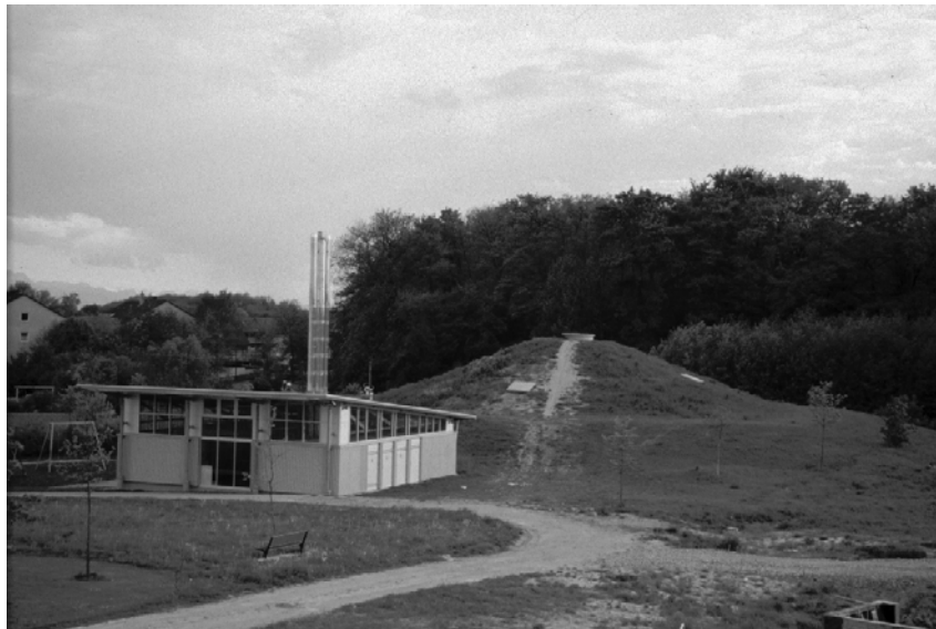
Abbildung 16: Saisonaler Wärmespeicher (12 000 m 3 ) in Wiggerhausen
