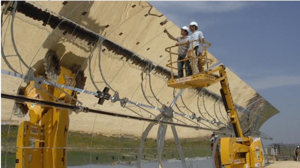
Marc Röger und sein Team vermessen Parabolspiegel und sorgen für die optimale Ausrichtung.
