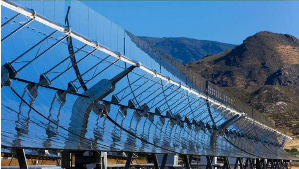
Die parabolförmigen Spiegel bündeln das Sonnenlicht auf dem Receiverrohr (helle Röhre im Focus des Spiegels). Hier wird die Sonnenstrahlung in Wärme umgewandelt. Die Wärme wird in mittels Wasserdampf, Thermoöl oder flüssigem Salz in den Receiverrohren in Richtung Turbine geleitet. Für den optimalen Ertrag eines Solarkraftwerks müssen die Spiegel sehr präzise ausgerichtet sein.
