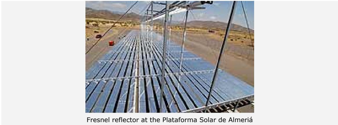
Fresnel reflector at the Plataforma Solar de Almería
