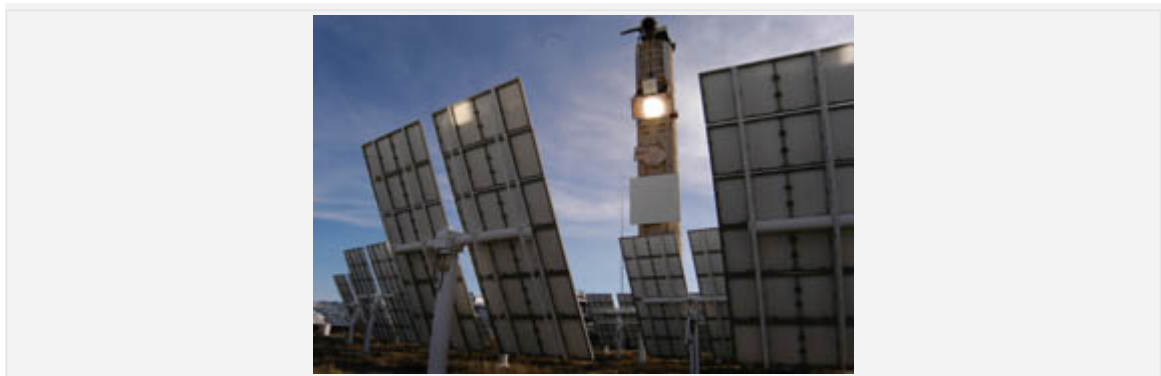
Solarturm-Anlage CESA-1 auf der Plataforma Solar im südspanischen Almeria.
