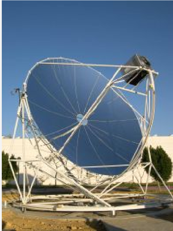
Die erste netzeinspeisende Dish/Stirling-Anlage in Sevilla
