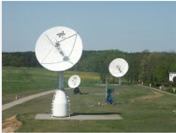
Das Antennenfeld der DLR-Außenstelle Neustrelitz. Hier werden die Daten von Fernerkundungs- und wissenschaftlichen Kleinsatelliten wie CHAMP und GRACE empfangen (Bild: DLR/DFD)
