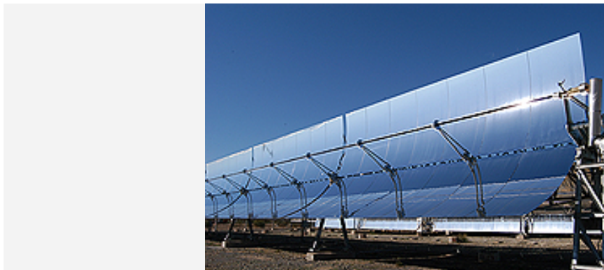
Die Sonne nutzen: Parabolrinnenanlage in Almería (Südspanien)
