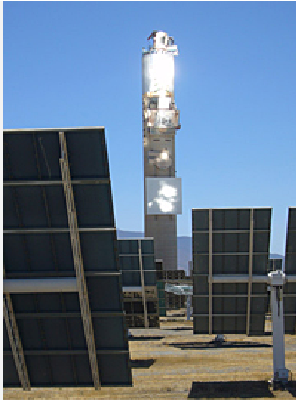
Turmkraftwerke: Stromerzeugung mit Sonnenstrahlen
