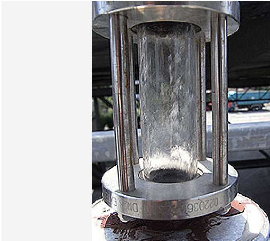
Wasser- / Dampfströmung bei 4 bar und 143°C
