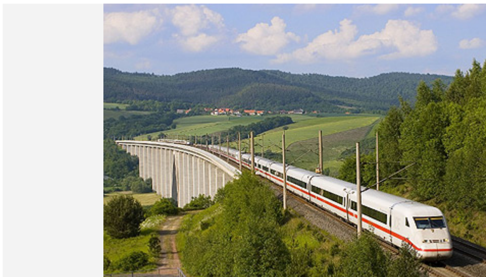
ICE 2 auf der Fuldataalbrücke
