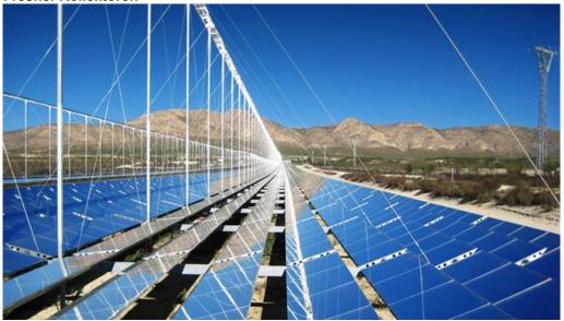
Bei Linear-Fresnel-Kollektoren bündeln mehrere ungewölbte Spiegelstreifen das Sonnenlicht auf ein Absorberrohr. Die einzelnen Spiegelstreifen werden dabei der Sonne einachsig nachgeführt. Das Fresnel-Solarfeld Puerto Errado steht in Calasparra, bei Murcia im Süden Spaniens.
