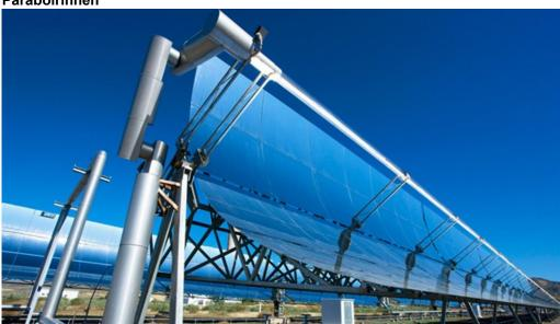
Bei Parabolrinnenkraftwerken wird die Sonnenstrahlung auf ein Receiver-Rohr im Fokus des Spiegels konzentriert. Die Wärmeenergie im Rohr wird weitergeleitet, mit ihrer Hilfe wird Wasserdampf erzeugt, der, wie in einem konventionellen Kraftwerk, eine Turbine antreibt.
