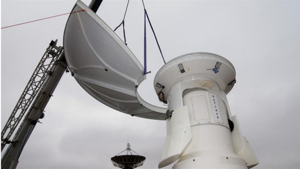
Die neue Antenne besteht aus sieben Segmenten, von denen jedes 150 Kilogramm schwer ist.
