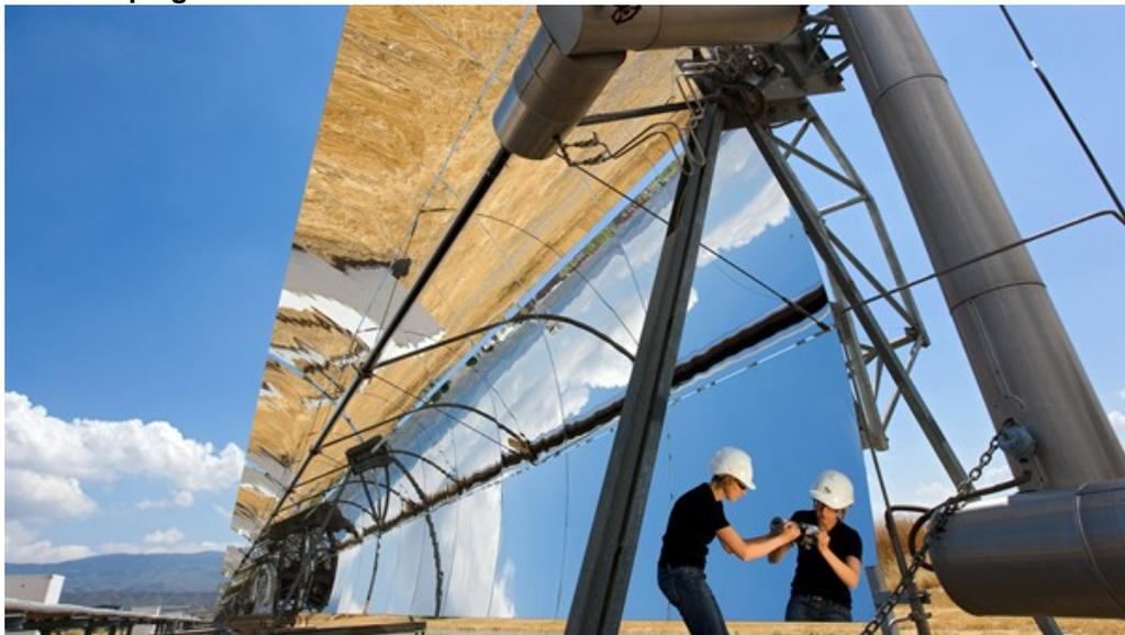
Parabollinienkollektoren fokussieren die Sonne linienförmig und lenken die Strahlen auf ein Receiverrohr. Dort erhitzen sie ein Wärmeträgermedium, das Dampf erzeugt, der wie in einem konventionellen Kraftwerk eine Turbine antreibt.
