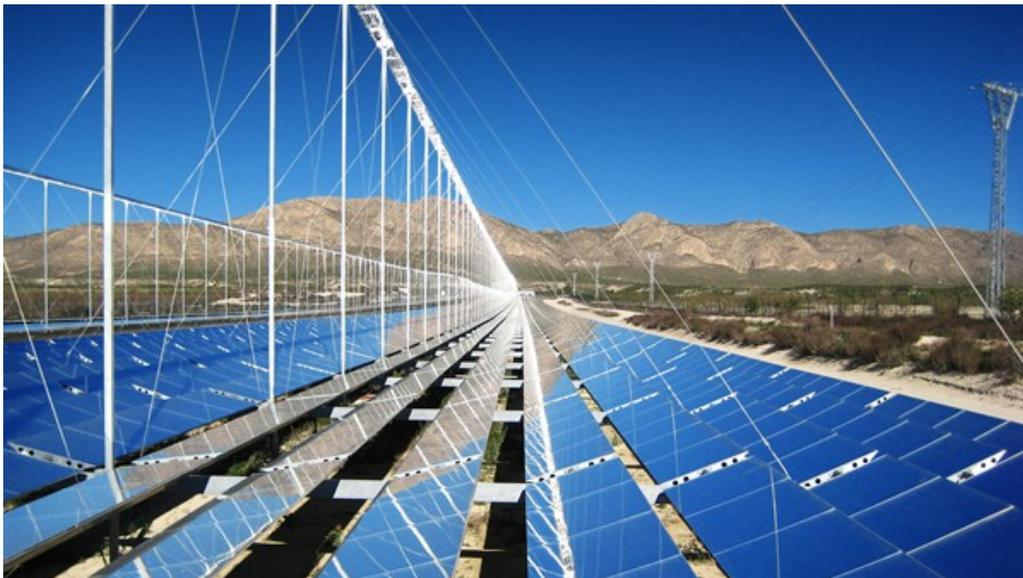
Bei Linear-Fresnel-Kollektoren bündeln mehrere ungewölbte Spiegelstreifen das Sonnenlicht auf ein Absorberrohr. Die einzelnen Spiegelstreifen werden dabei der Sonne einachsigt nachgeführt. Das Fresnel-Solarfeld Puerto Errado steht in Calasparra, bei Murcia im Süden Spaniens.
