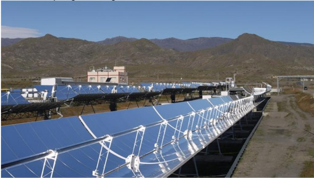
In der Testanlage DUKE (Durchlaufkonzept – Entwicklung und Erprobung) auf der Plataforma Solar in Almería (Spanien) wird der Wasserdampf, der die Turbine antreibt, direkt im Receiverrohr erzeugt. In den heutigen Anlagen wird dort ein Wärmeträgeröl erhitzt.
