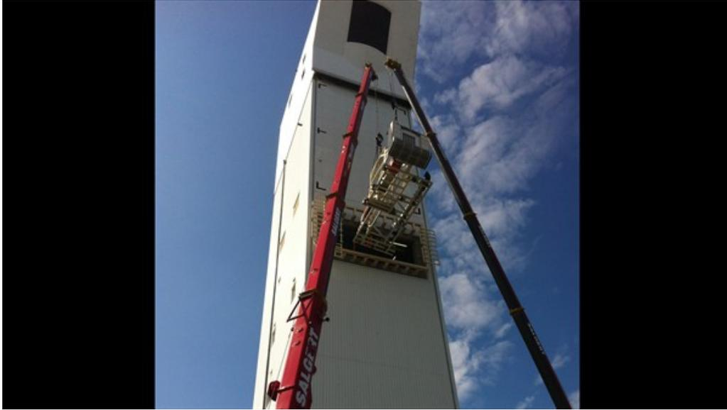
Mit zwei Mobilkränen wird der neue Testreceiver auf der Forschungsebene des DLR-Solarturms in Jülich eingebaut. Auf der Forschungsebene ist der Testreceiver für die Wissenschaftler leicht zugänglich. Sie können Messsonden einbauen und einzelne Komponenten austauschen.
