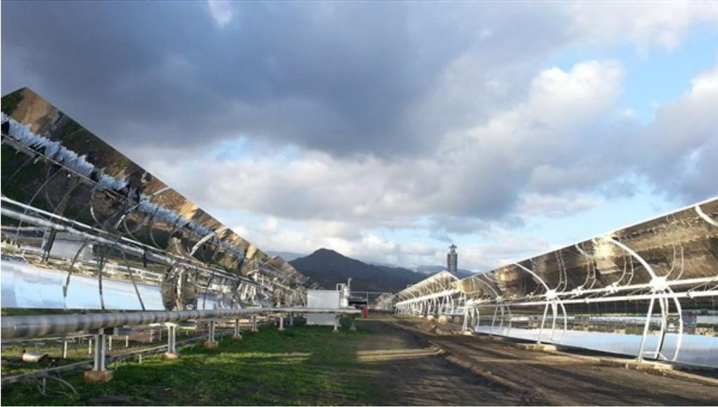
In der Testanlage DUKE (Durchlaufkonzept – Entwicklung und Erprobung) wird der Wasserdampf für die Stromerzeugung direkt in den Receiverrohren der Parabolrinnen erzeugt. Zwischenschritte über Wärmeträgermedien fallen damit weg, zudem sind höhere Betriebstemperaturen möglich.
