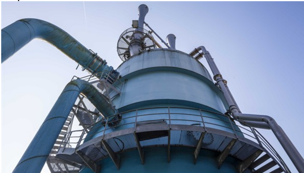
Außenansicht des Höhengsimulations-Prüfstands P4 am Standort Lampoldshausen
