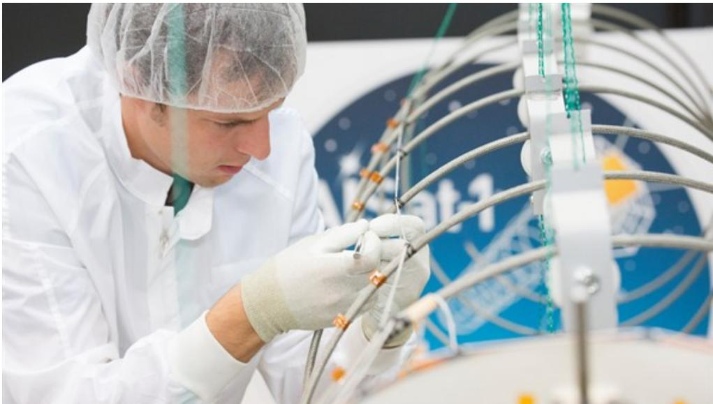
Bisher wird der Schiffsverkehr mit Satelliten überwacht, die mit einer ungerichteten Stab-Antenne ausgestattet sind und in dicht befahrenen Gebieten die einzelnen Schiffssignale kaum unterscheiden können. Für den Satelliten AISat entwickelte das Deutsche Zentrum für Luft- und Raumfahrt (DLR) deshalb eine vier Meter lange Helix-Antenne und baute für die Mission einen Satelliten sowie Empfänger. Gesteuert und betrieben wird der Satellit vom DLR-Institut für Raumfahrtsysteme in Bremen.
