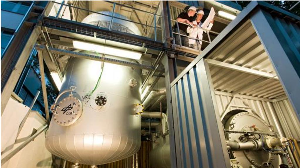
Das DLR bindet den Hochtemperaturspeicher HOTREG zur thermischen Energiespeicherung digital in das Energy Lab 2.0 ein. Die in der Anlage gespeicherte Hochtemperaturwärme kann entweder zur Bereitstellung von Prozesswärme oder zur Rückverstromung genutzt werden.
