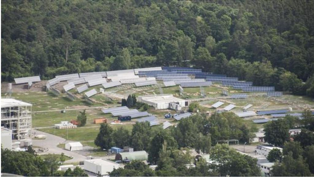
Solarzellen, Batterien und Wechselrichter in einer 1-Megawatt-Anlage erzeugen und puffern Solarstrom netzverträglich / Neue und sichere Technologie als Baustein für die Energiewende.
