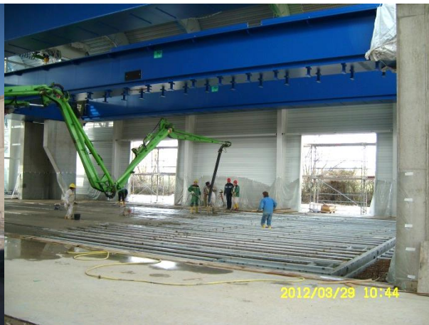
03/2012: Einbringen der Grundstruktur des Spannfelds
