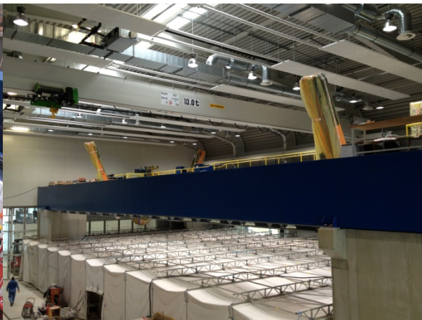
03/2013: Finale Ertüchtigung des Spannfelds
