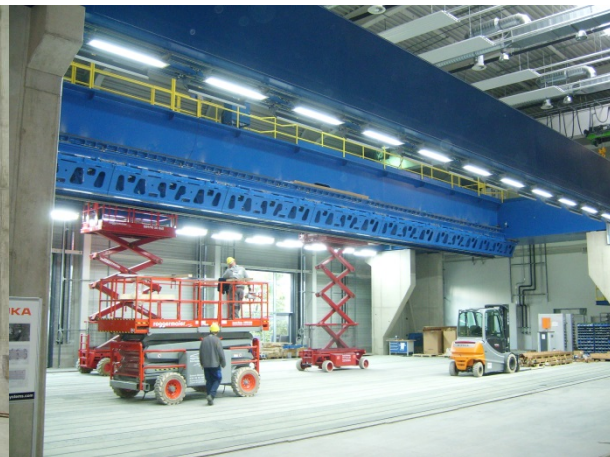
09/2012: Fertigstellung Oberes Maschinengestell und Einbringung der zentralen Linearachse
