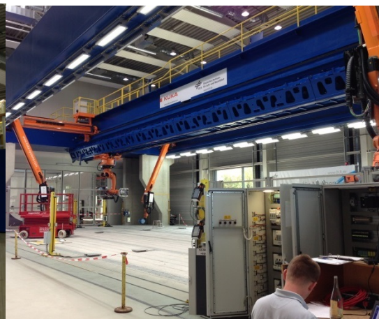
08/2013: Durchführung der Erst- Inbetriebnahme
