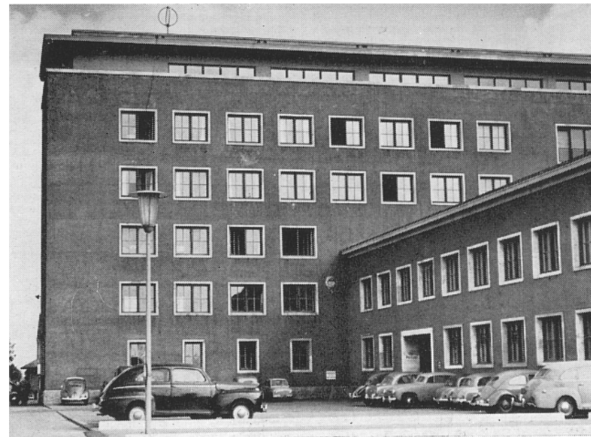
Flughafen-Betriebsgebäude Riem Bauteil V → Forschungsinstitut im Obergeschoß
