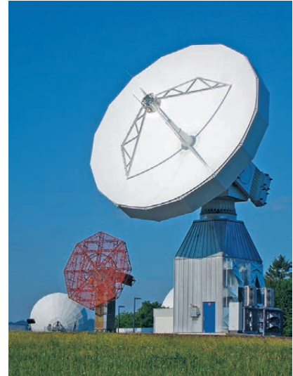
Die 13-Meter-Antenne mit höchsten Anforderungen in Herstellungsgenauigkeit und Bewegungspräzision. Der Parabolspiegel ist auf ein Zehntel Millimeter genau gefertigt und trotz dabei allen saisonalen Außentemperaturen.
