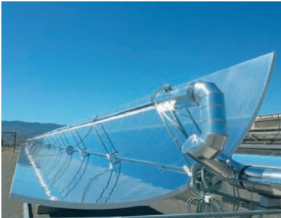
Direkte Dampferzeugung an Parabolrinnen auf der Plataforma Solar in Spanien
