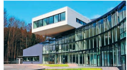
Neugestalteter Eingangsbereich des Standorts Lampoldshausen
