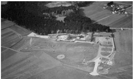
Luftaufnahme des Flughafens und FFO-Gelände, 1938
