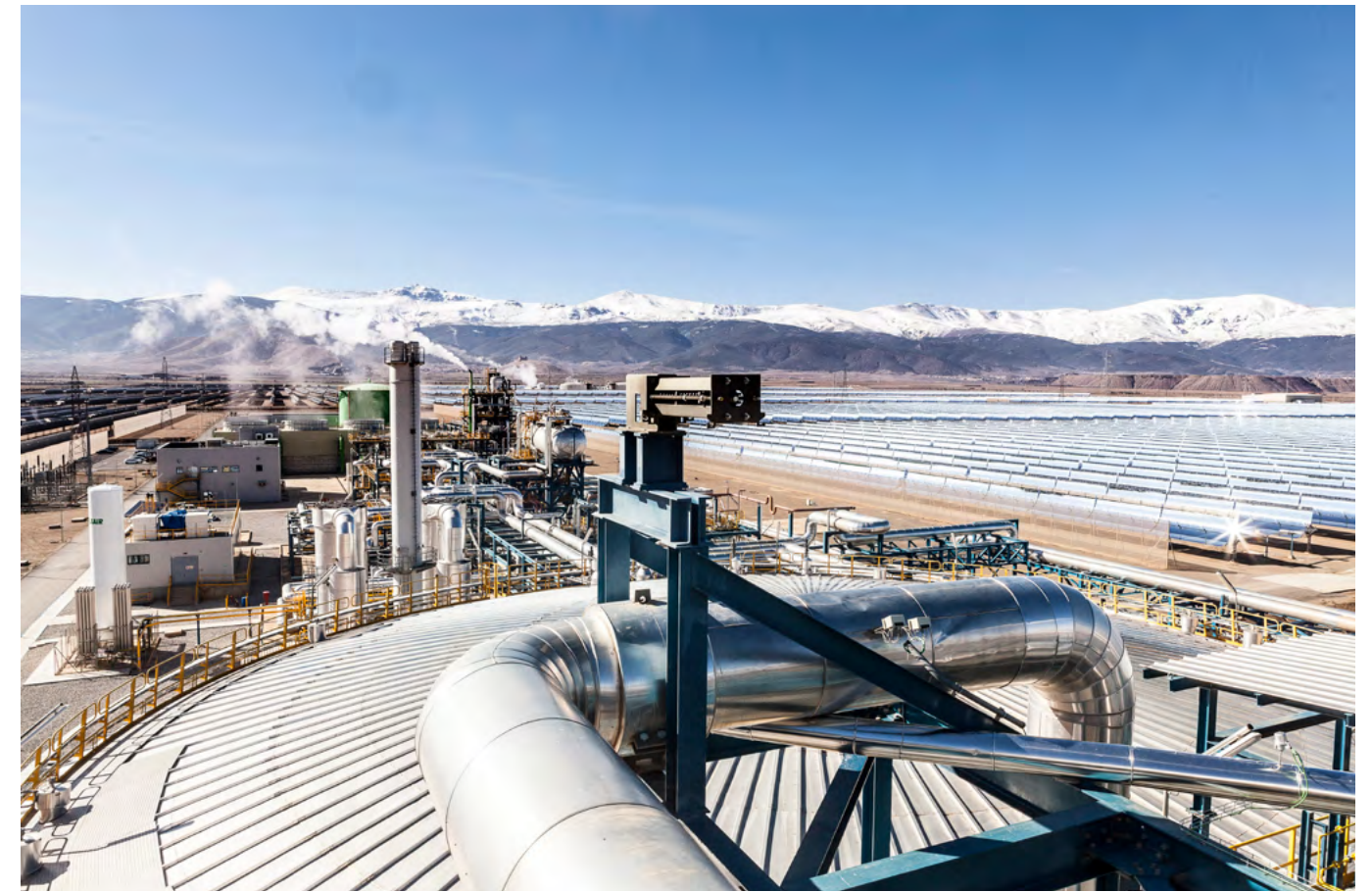
Speicher und Kraftwerksteil des Parabolinnenkraftwerks Andasol 3. Bild: Marquesado Solar
