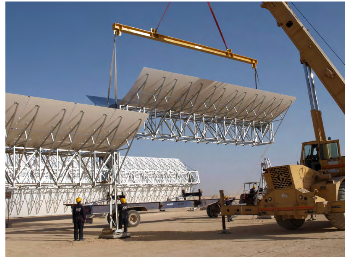
Montage von Kollektoren eines Parabolrinnenkraftwerks. Bild: sbp sonne
