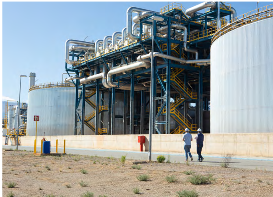
Wärmespeicher entkoppeln die Stromerzeugung von der „Ernte“ der Solarenergie. Bild: CSP Services
