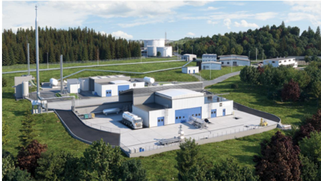
Seit Anfang 2018 erweitert das DLR den Forschungs- und Technologieprüfstand P8 um eine dritte Testzelle. DLR-Ingenieure entwickeln bereits einen Demonstrator namens LUMEN (Liquid Upper Stage Demonstrator Engine), um das Verhalten eines kompletten Flüssigkeitsraketenmotorzyklus und seiner Teilkomponenten in repräsentativer Umgebung zu untersuchen.
