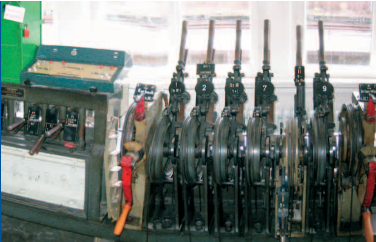
Das hohe Alter von Leit- und Sicherungstechnik, wie dieses über 80 Jahre alten mechanischen Stellwerks (links) oder des Relaisstellwerks mit seinen über 40 Jahren (rechts), ist häufig die Ursache für Verspätungen im Bahnverkehr
