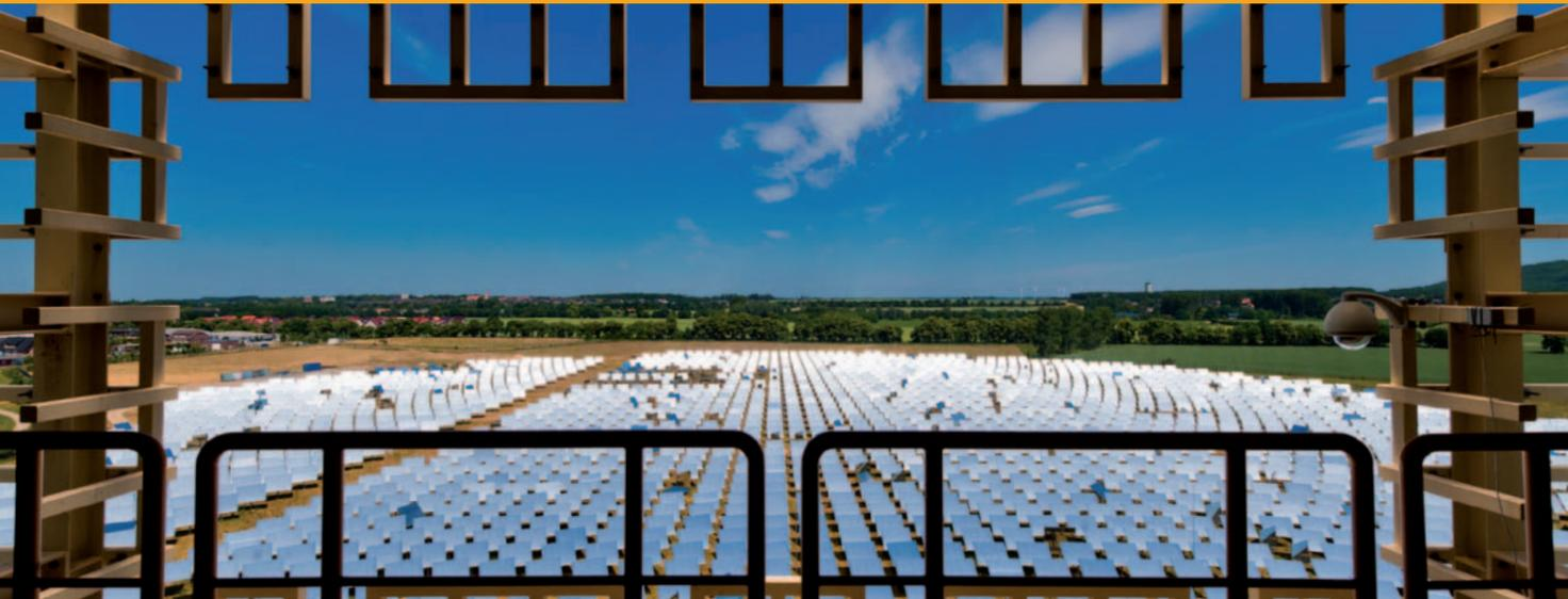
Blick aus dem Jülicher Solarturm: Die 2.153 Spiegel stehen auf einer circa acht Hektar umfassenden Fläche
