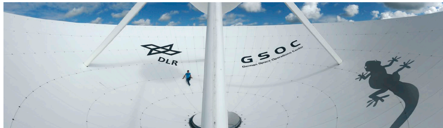
Gewaltige Antennen halten die Kommunikationsverbindung von der Erde zum Satelliten und umgekehrt. Für das Galileo-System ist es notwendig, Signalverzerrungen genauestens zu kennen. Dazu vermisst das Institut für Kommunikation und Navigation die Signale. Hierbei kommt die 30-Meter-Antenne des DLR in Weilheim zum Einsatz.
