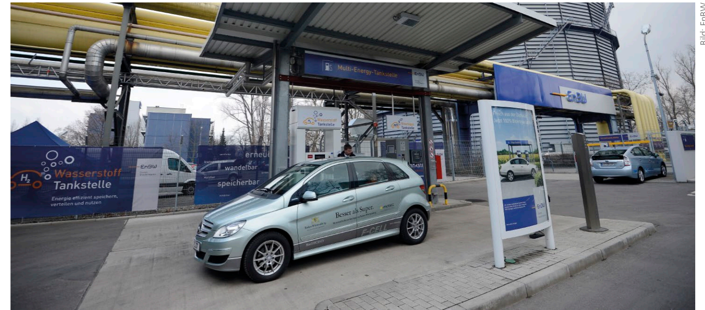
Zukunftstechnologie im Praxistest: EnBW-Wasserstofftankstelle in der Stuttgarter Talstraße
