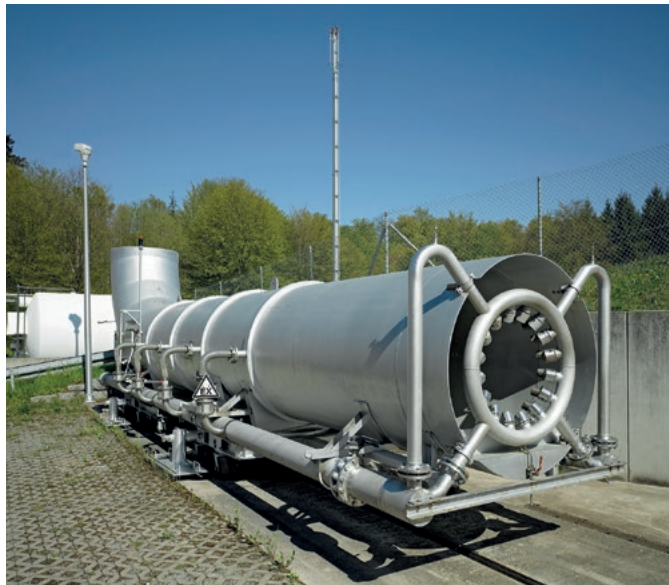
Je mehr Schub die getesteten Triebwerke haben und je höher der Druck in der Brennkammer ist, desto lauter fallen die Tests im P8 aus – mit einem Leitrohr wird daher die Schall-Emission reduziert
