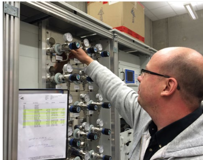
Frank Neuwinger, einer der Spezialisten für Emissionen von Brennkammern, ist für die Abgasmessungen zuständig. Er hat die Entwicklung der Luftfahrt- und Kraftwerksturbinen über die Jahre mitverfolgt.
