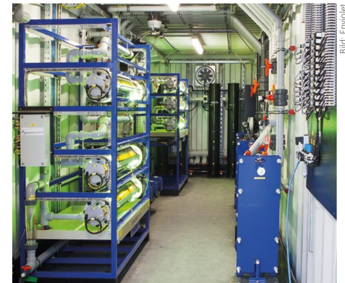
UV-Oxidationsanlagen zur Abwasserbehandlung, wie sie momentan auf dem Markt sind
