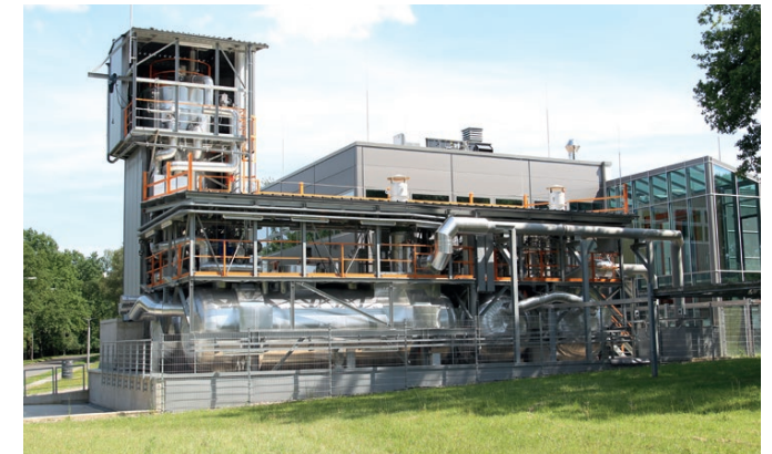
Forschen für die Energiewende: Hochtemperaturwärmespeicher sind ein Schlüssel zu regelbarem Strom aus erneuerbaren Energien. Mit der DLR-Anlage TESIS können Unternehmen Komponenten zur Speicherung von Flüssigsalz testen.
