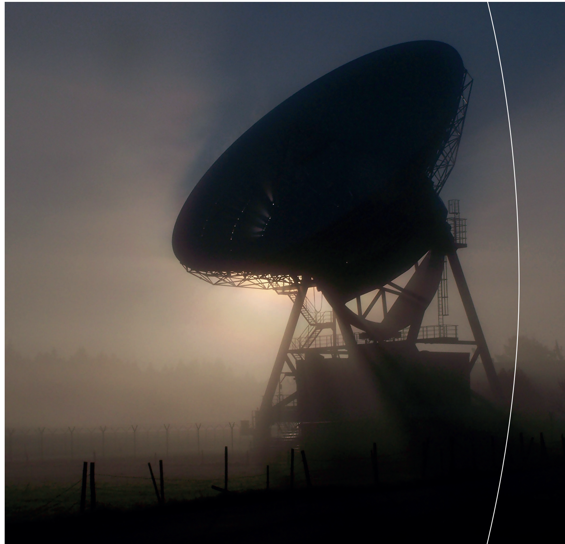
Das Wahrzeichen der Bodenstation Weilheim: die 30-Meter-Antenne. Sie wurde gebaut, um Kommandos an die 1974 und 1975 gestarteten Sonnensonden HELIOS zu senden.
