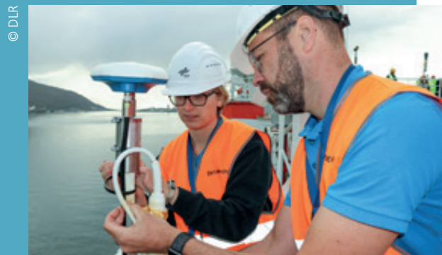
Montage der Empfangsantenne auf dem Peildeck. Für die see- und kältefeste Installation sorgen Dr. Simon Plass und die Expertin für Satellitennavigation im DLR-MOSaIC-Team, Friederike Fohlmeister.
