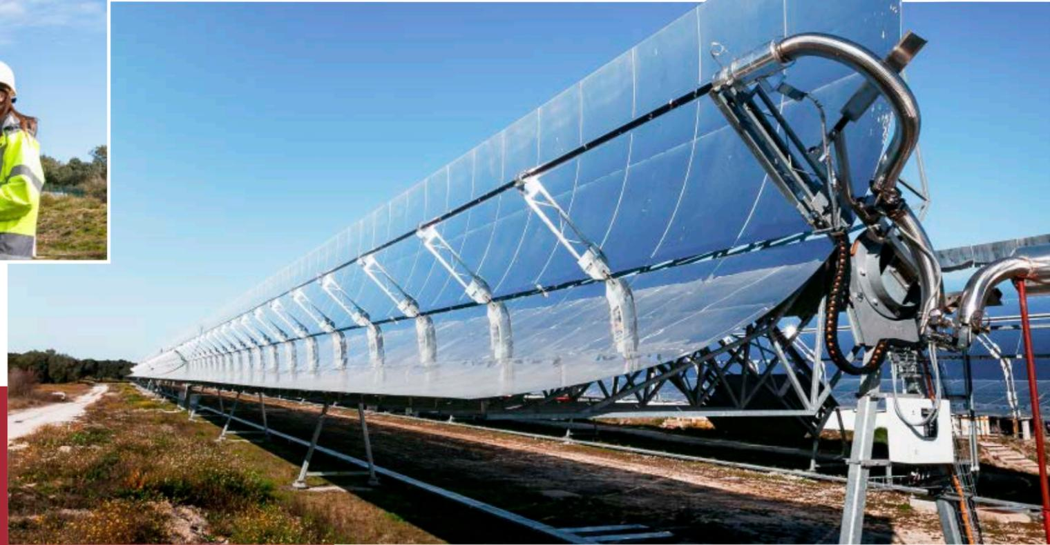
In der Testanlage wird flüssiges Salz, das durch das Metallrohr in der Mitte des Parabolspiegels fließt, mithilfe von Sonnenenergie erhitzt.
