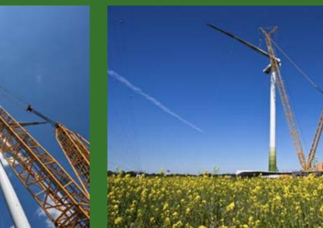
Mitte März wurden der Generator, das über 70 Tonnen schwere Maschinenhaus und die Rotorblätter für die Windenergieanlage OPUS 1 angeliefert. Der Transport der drei über 60 Meter langen Schwertransporter dauerte zwei Nächte. Zahlreiche Straßen mussten temporär gesperrt werden und Schilder, Laternen und Leitpfosten den Spezialfahrzeugen weichen. Im Mai 2023 wurde OPUS 2 montiert.
