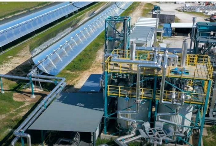
Auf der Évora Molten Salt Platform in Portugal forscht das DLR gemeinsam mit der Universität Évora daran, wie geschmolzenes Salz als Wärmeträgermedium in Solarkraftwerken eingesetzt werden kann. Bislang wird Öl als Wärmeträgermaterial in solchen Kraftwerken genutzt.
