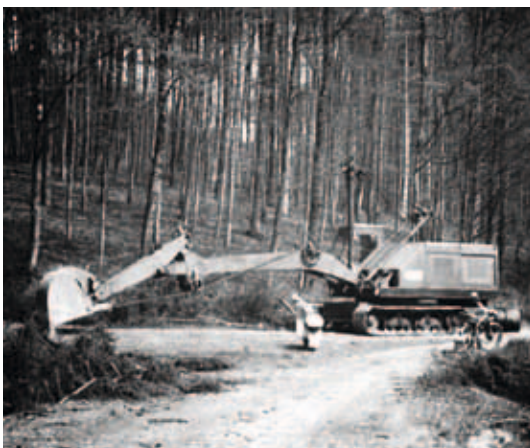
Am 19. April 1960 begannen die Bauarbeiten „Im Langen Grund“.
