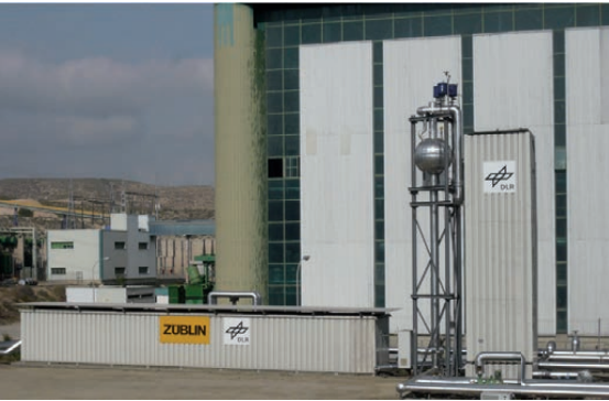
Demonstrations-Kombi-Speichersystem aus Beton-Feststoffspeicher (links) und Latentwärmespeicher (rechts)
