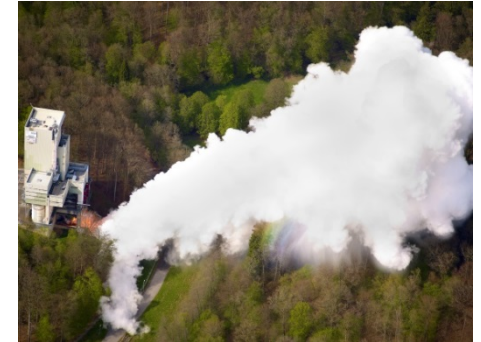
Außenaufnahme des Prüfstandes P5 bei laufendem Test des Hauptstufentriebwerkes der Ariane 5
