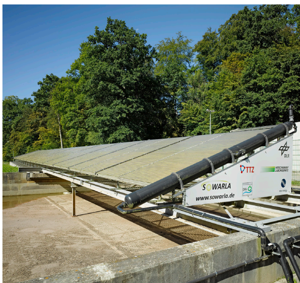
Die solare Abwasserreinigungsanlage (SOWARLA) am DLR-Standort Lampoldshausen dient Demonstrations- und Forschungszwecken
