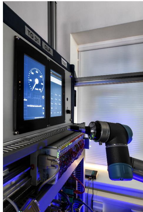
Testumgebungen wie das RailSiTe ® ermöglichen es, Testzyklen zu reduzieren und Sicherheitsstandards zu erhöhen. (Quelle: DLR)
