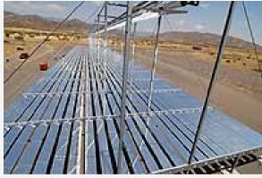
Fresnel reflector at the Plataforma Solar de Almeriá
